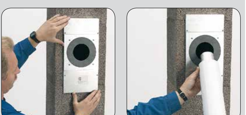
III.a i - Uzasadka przewodu spalnego 2 - Maskownica metalowa III.b i - Uzasadka przewodu spalnego 2 - Maskownica metalowa dołoty powietrza III.c Osadzić maskownicę metalową. III.d Montaż koncentrycznej rury powietrzno-spalnej w trybie przeciwprąd.
