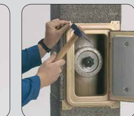
Va Osadzić zaślepkę rewizyjną. Vb Drzwiczki rewizyjne przybić gwóźdźkami do pustaka. Vc Ramkę drzwiczek otykować. Vd Komin otykować zaprawą cementowo-wapienną.
