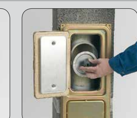
Ia Drzwiczki wyczystkowe z osłoną umieścić na otworach i przybić gwóźdźkami do pustaka. Ib Osadzić zaślepkę rewizyjną.
