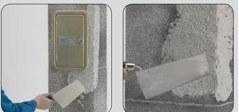
Va Osadzić zaślepkę rewizyjną. Vb Drzwiczki rewizyjne przybić gwóźdźkami do pustaka. Vc Ramkę drzwiczek otykować. Vd Komin otykować zaprawą cementowo-wapienną.
