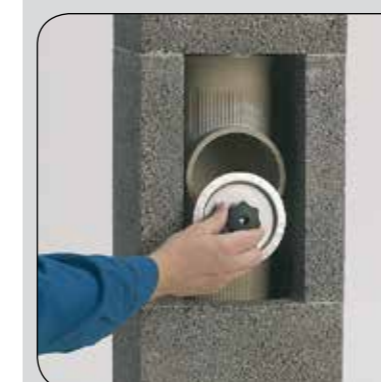
Va Osadzić zaślepkę rewizyjną. Vb Drzwiczki rewizyjne przybić gwóźdźkami do pustaka. Vc Ramkę drzwiczek otykować. Vd Komin otykować zaprawą cementowo-wapienną.
