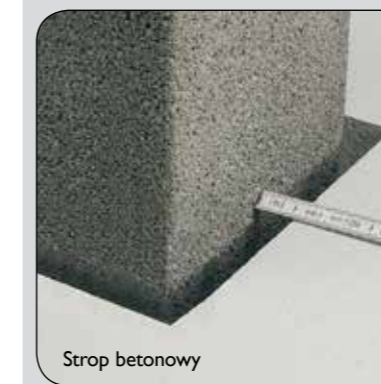
IVa Otwór przejścia stropowego i dachowego musi być ze wszystkich stron większy od wymiaru zewnętrznego pustaka o min. 2,3 cm. Wólbę przestrzeli wypełnić wełną mineralną i zaląć betonem (nie stosować styropianu). IVb Przejście kominu przez strop drewniany. IVc Przejście kominu przez strop betonowy. IVd Alternatywne wykonanie przejścia kominowego przez konstrukcję dachu. Montaż uchwyty kominowego Schiedel.
